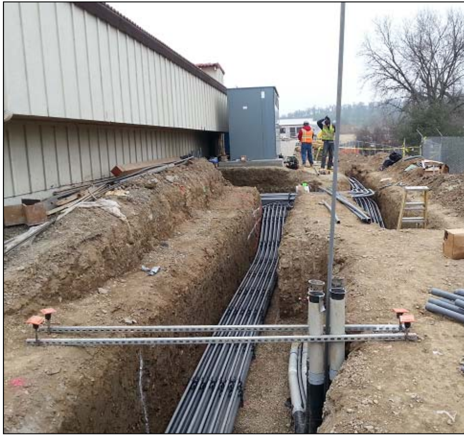
Future power conduit trenches
